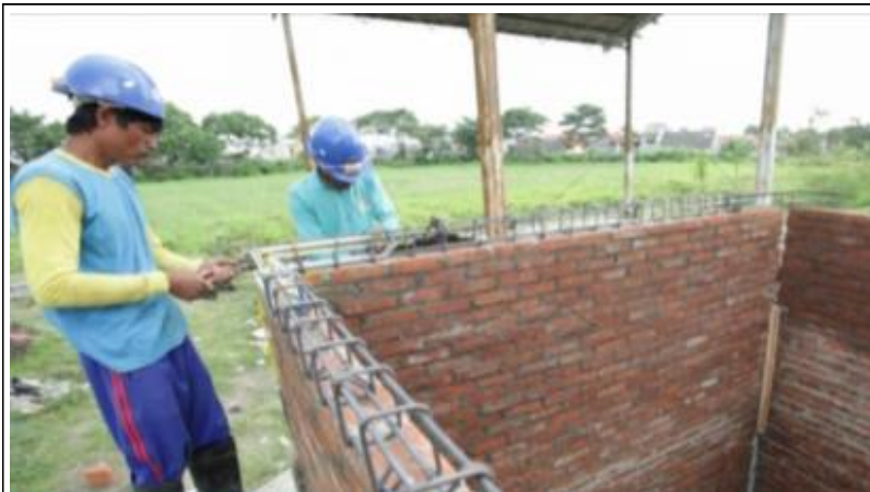
Gambar 58. Pengecoran Balok Pengikat/ Sloof
