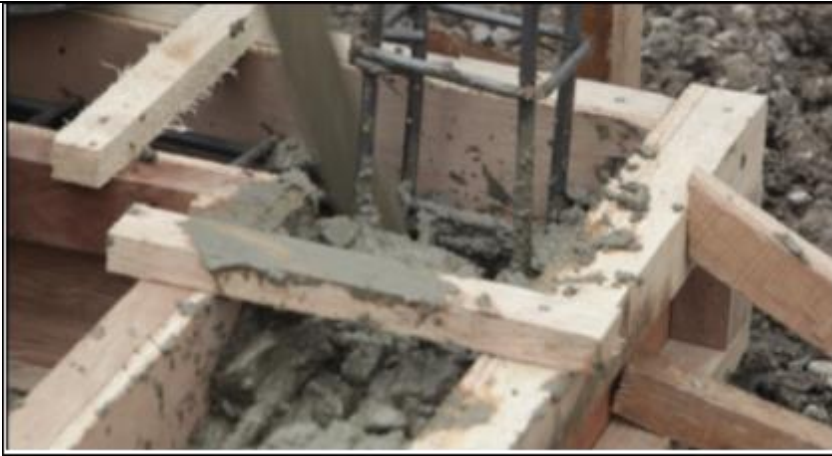
Gambar 58. Pengecoran Balok Pengikat/ Sloof
