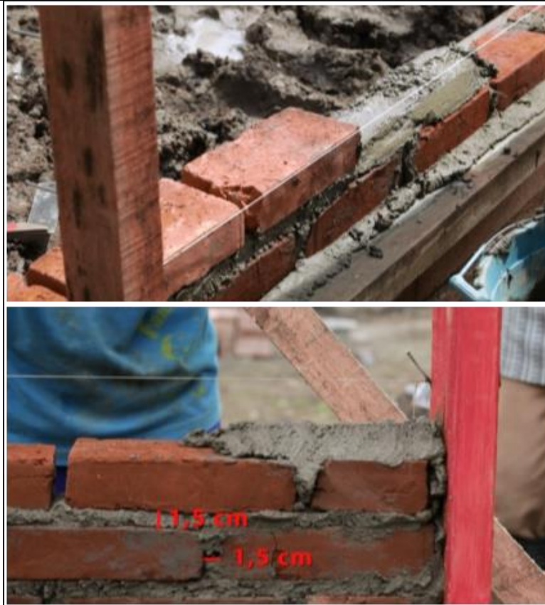
Gambar 41. Proses Pemasangan Batu Bata Untuk Dinding
