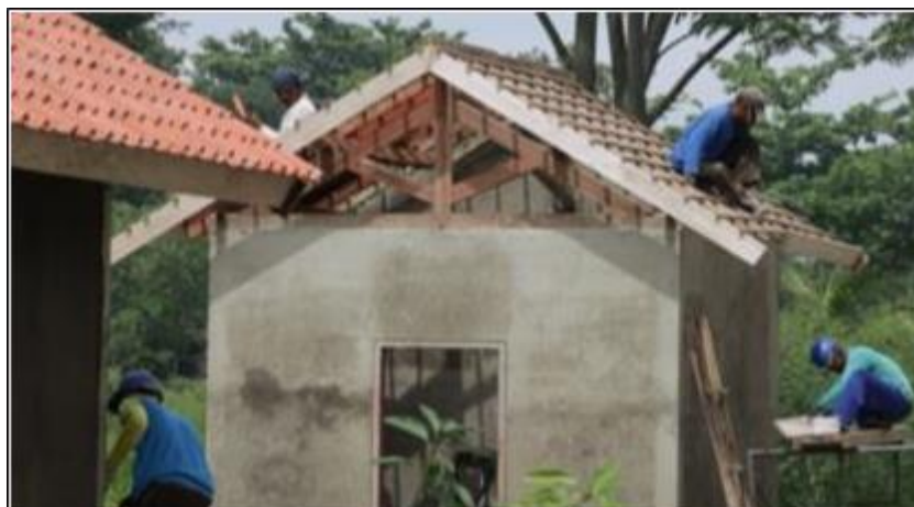
Gambar 27. Kuda-kuda Kayu Pada Atap Rumah Tinggal
