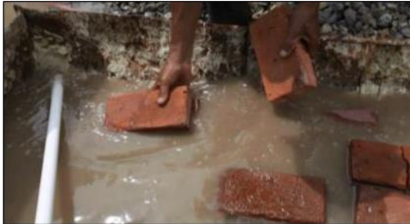
Gambar 15. Perendaman Batu Bata Sebelum Dipasang
