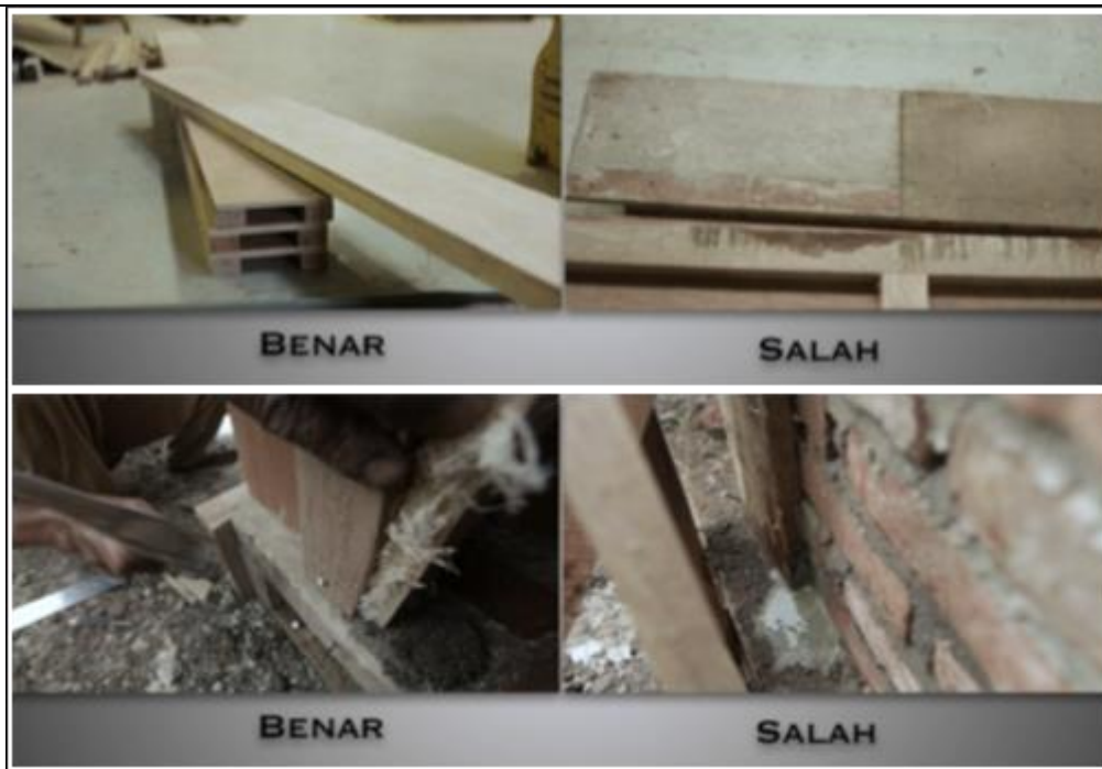
Gambar 54. Kualitas Cetakan/ Bekisting
