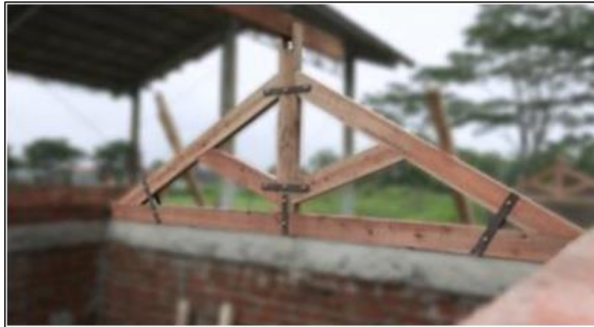
Gambar 28. Kuda-kuda Kayu Dengan Pengikat Plat Baja
