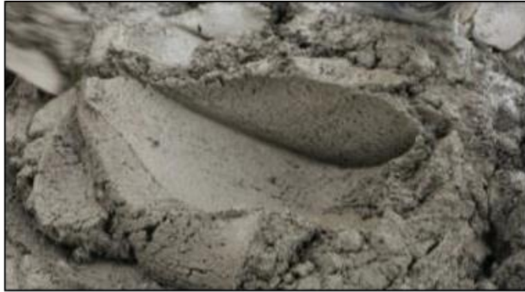
Gambar 9. Hasil Pencampuran Mortar Yang Baik
