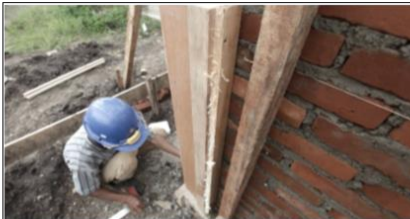
Gambar 55. Pemasangan Cetakan/ Bekisting Untuk Kolom
