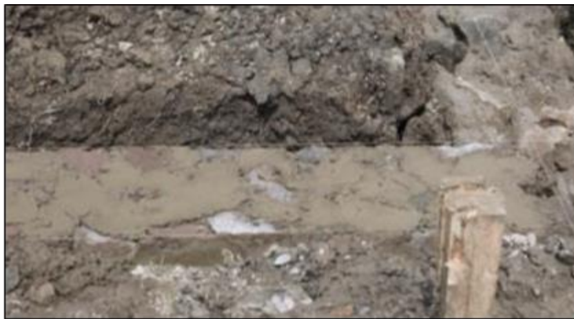
Gambar 11. Pondasi Dari Batu Kali/Gunung
