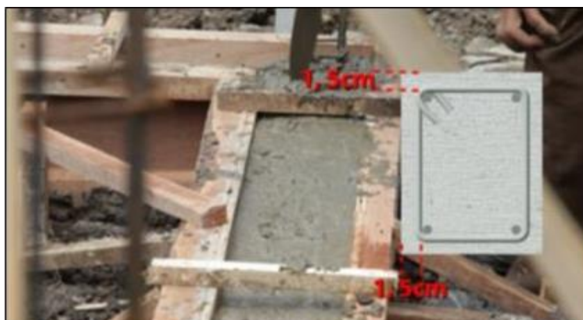
Gambar 19. Balok Pengikat/ Sloof
